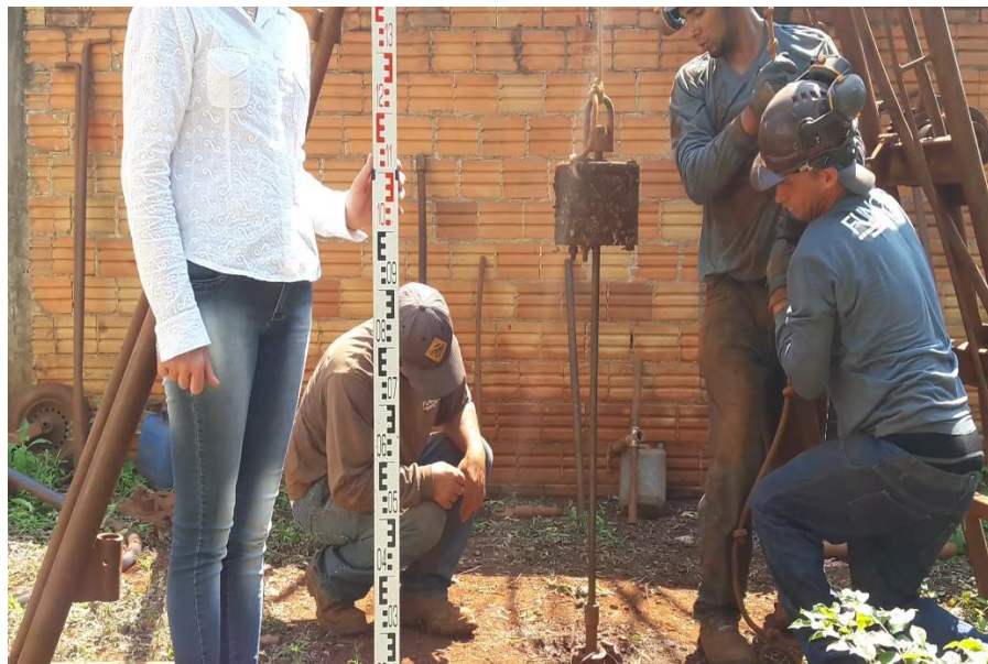
Figura 4 – Mira topográfica como medida de referência no equipamento manual
