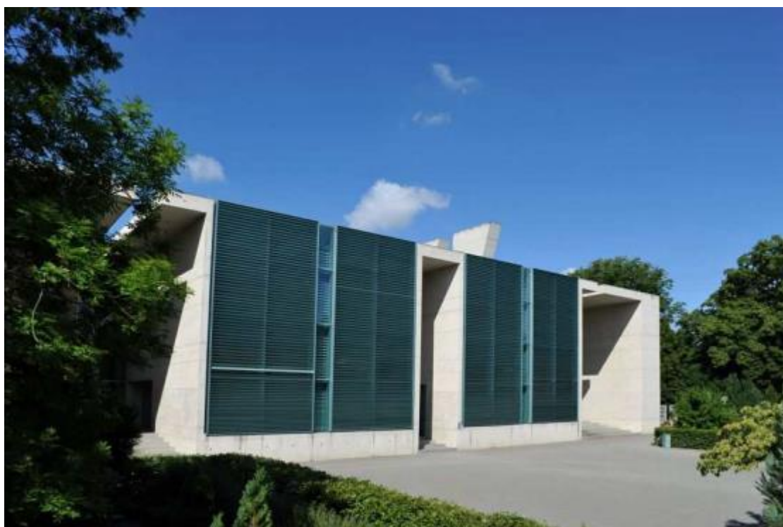
Figura 07 - Fachada nordeste do Crematório de Baumschulenweg
