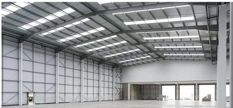
Figura 20 - Galpão Pré - Moldado.
