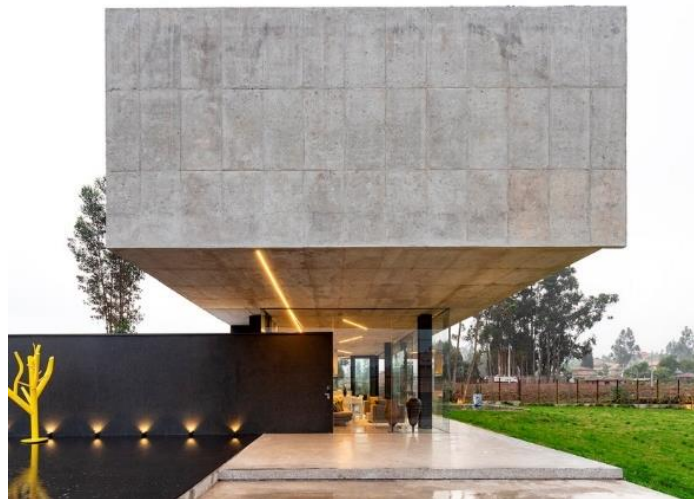
Figura 53 - Concreto aparente.
