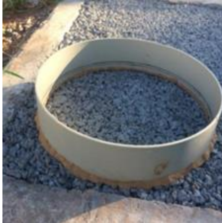
Figura 07: Anel de infiltração.
