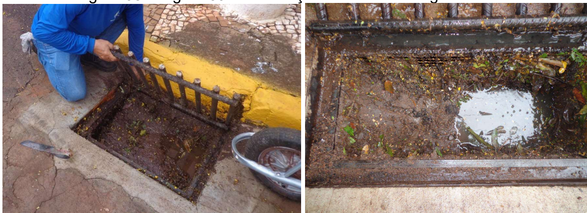
Figura 38 e Figura 39: Manutenção do Bueiro inteligente.
