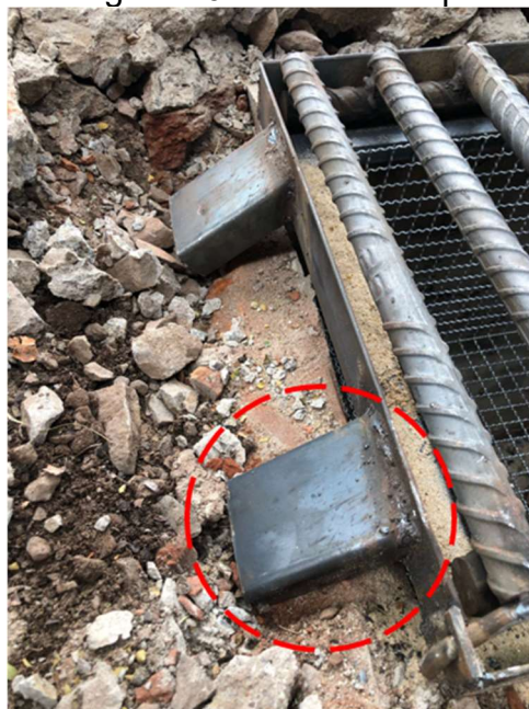
Figura 26: Detalhe do apoio.
