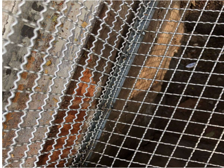
Figura 22: Malha do cesto coletor 2 cm x 2 cm.
