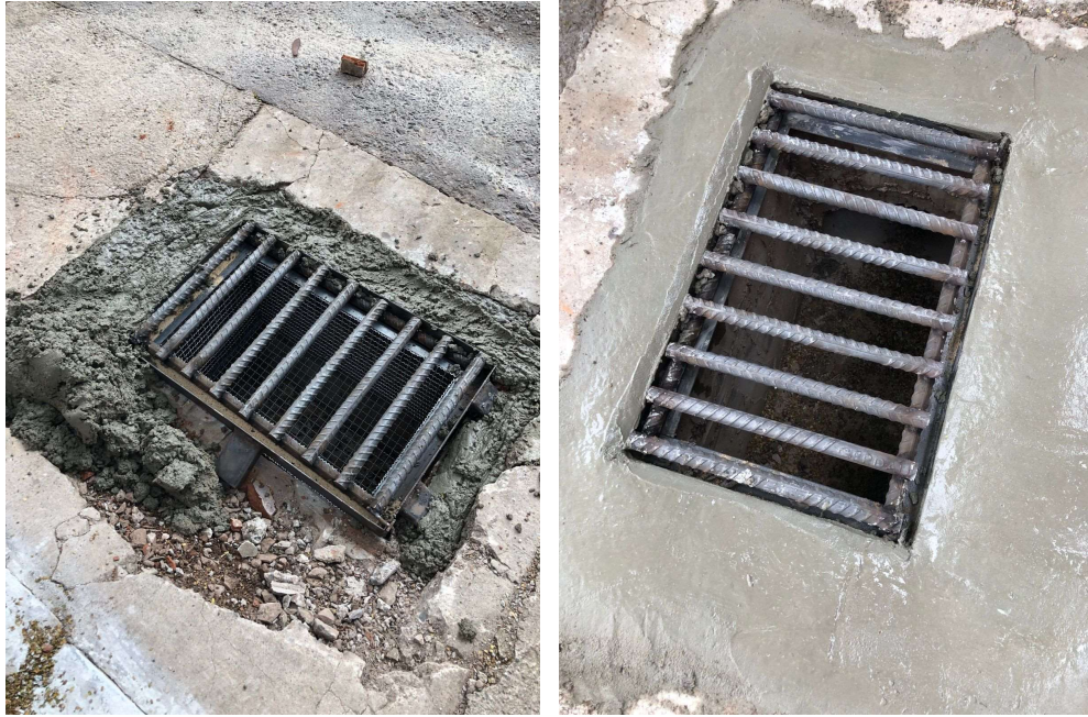
Figura 27 e Figura 28: Concretagem do bueiro inteligente.
