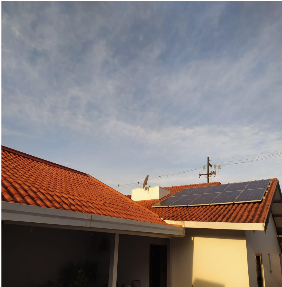
Figura 4: Telhados da residência do estudo de caso
