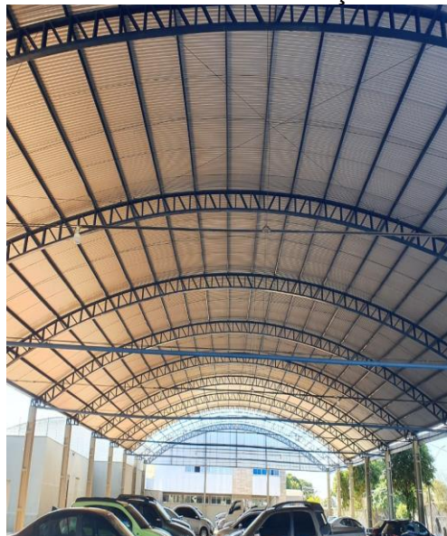
Figura 20: Estrutura da edificação estudada.
