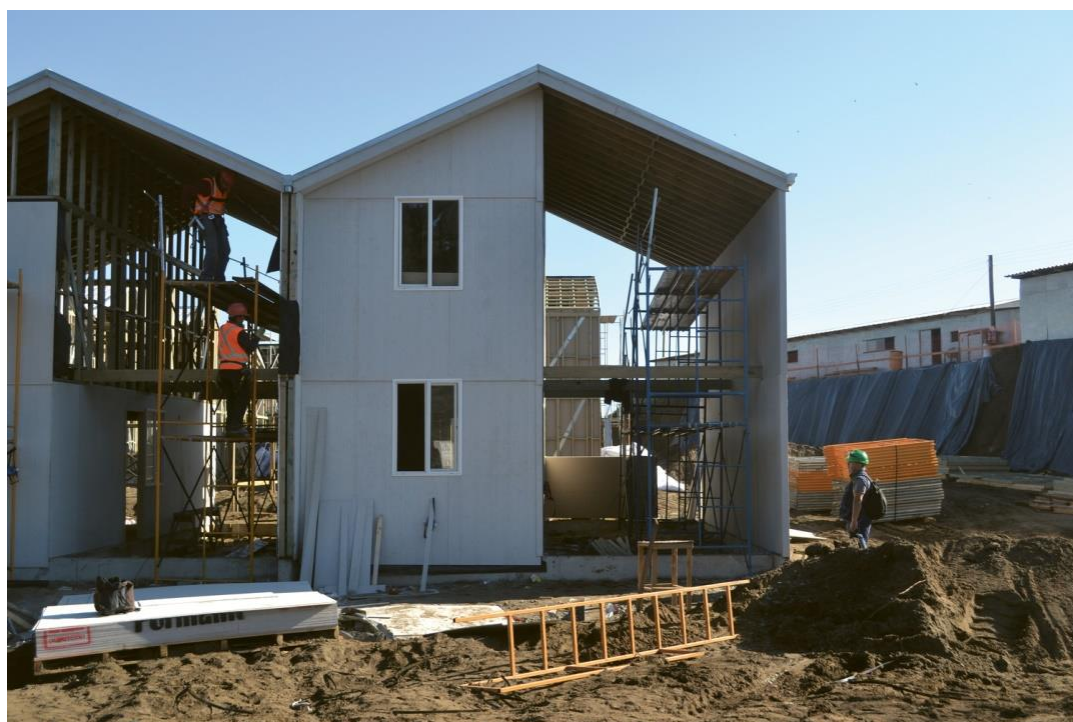
Figura 7 – Habitação Villa Verde / Elemental Em Construção
